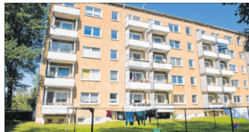
Wohnblock aus den 1960er Jahren an der Ringstraße. Er soll mit Mitteln des sozialen Wohnungsbaus saniert werden.
