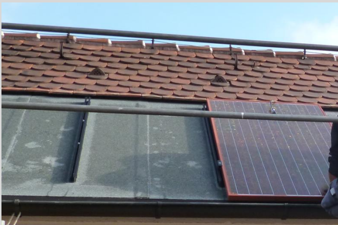
Bild 4: Indach-Unterkonstruktion
