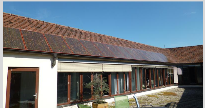
Bild 3: PV-Anlage auf dem Neuen Rathaus, Hauptmarkt 18
